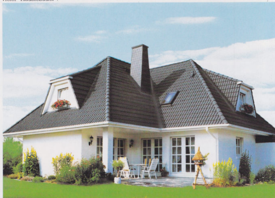
Das "Haus Wangerooge" mit rd. 190 m 2 Wohnfläche und rd. 90 m 2 Kellergeschossfläche ist der Traum vieler "Häuslebauer".
