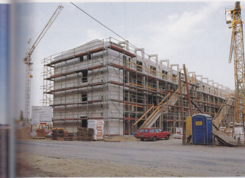
Schlüsselfertiger Bau von 67 Wohneinheiten im Hollergrund
