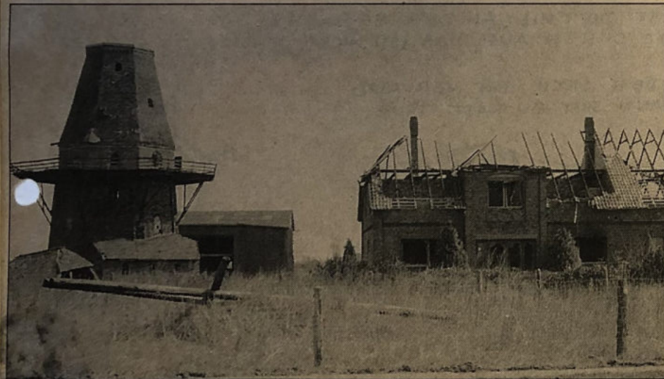
Als trostlos Ruine präsentiert sich derzeit die Mühle samt Nebengebäuden. 23. 11. 96 Foto: Sperling
