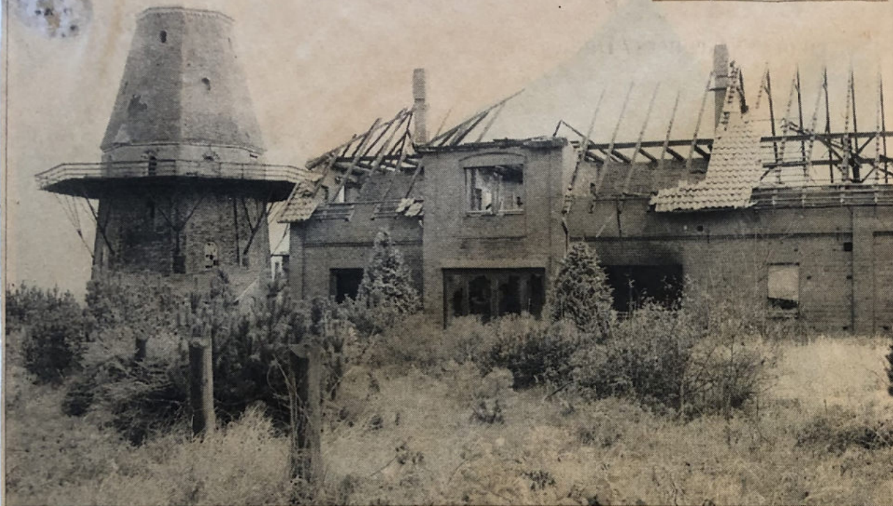
Jahrelang vernachlässigt und nach zwei Bränden nur noch ein, trostloser Anblick: Die Mühle und das Müllerhaus in Blender. Jetzt hat sich ein Förderverein gegründet, der sich für die Sanierung der Gebäude einsetzen will. Erste Aktionen sind bereits geplant. Foto: Monika Jäger
