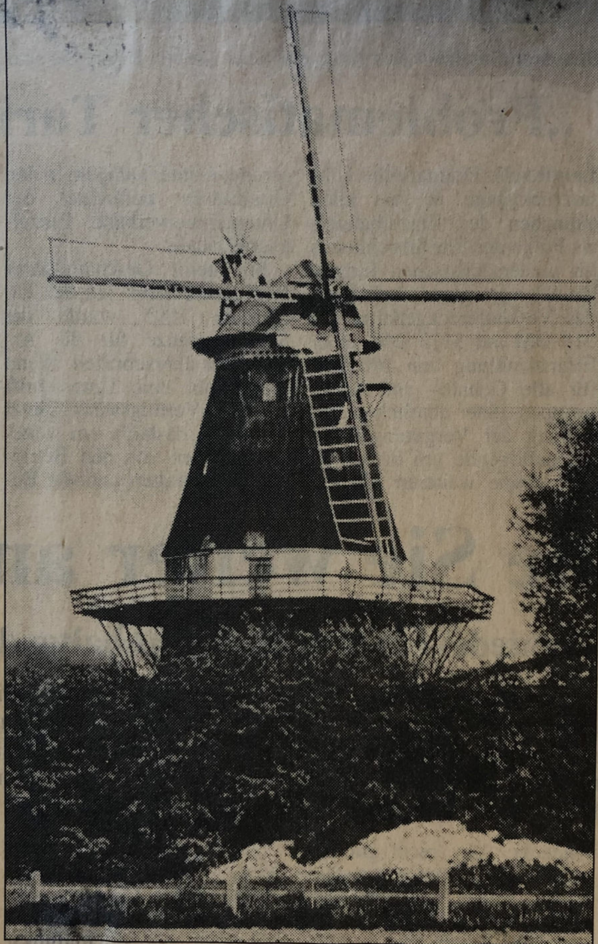
Aus den 50er Jahren stammt diese Aufnahme. Sie zeigt die Blen- der Mühle noch in voller Pracht. Nun wartet man auf den Beginn der Restaurierung. Sie ist nötig, um das Gebäude auf Dauer zu erhalten.
