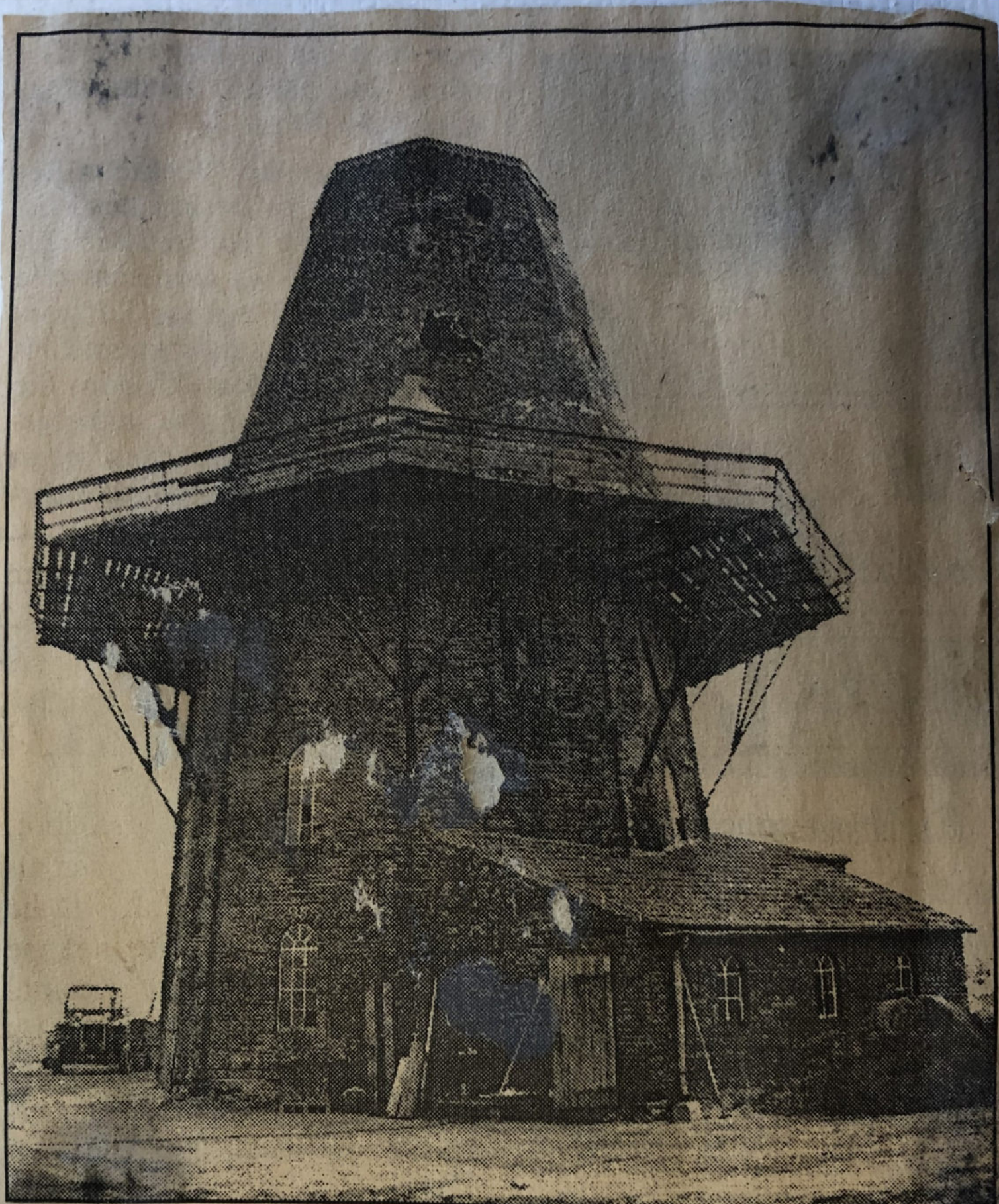
„Opfer“ eines Streits zwischen Behörde und Besitzer: die Blendermühle an der Landesstraße 203. 14.12.91 Fotos (4): Bohlken
